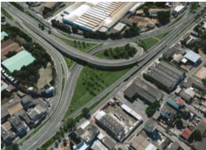
Figura 49: Viaduto de Carapina - Imagem Google Earth 2015
