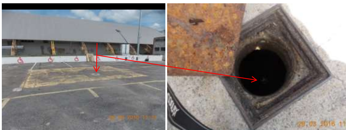
Figura 120: Indicação de Caixa de armazenamento de 32.000 litros ao lado do Pavilhão 01
