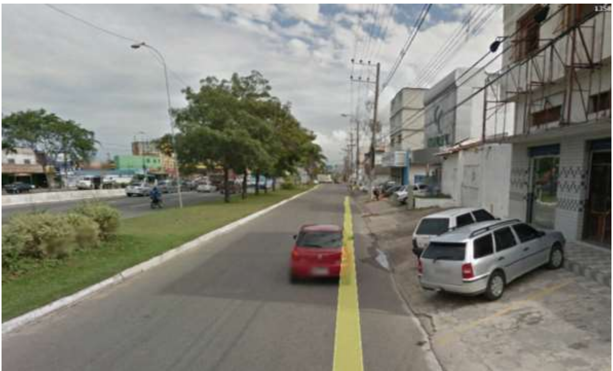
Figura 52: BR 101 - Pista Lateral - Trecho Boa vista (Imagem Google Earth 2014).
