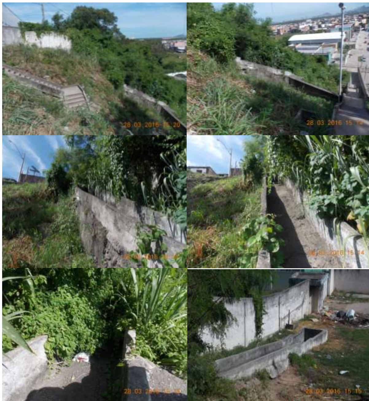
Figura 132: Registro fotográfico escada dissipadora 02
