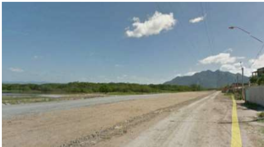
Figura 144: Limite de jardim carapina com Zona de Proteção Ambiental 1- Área de manguezal
