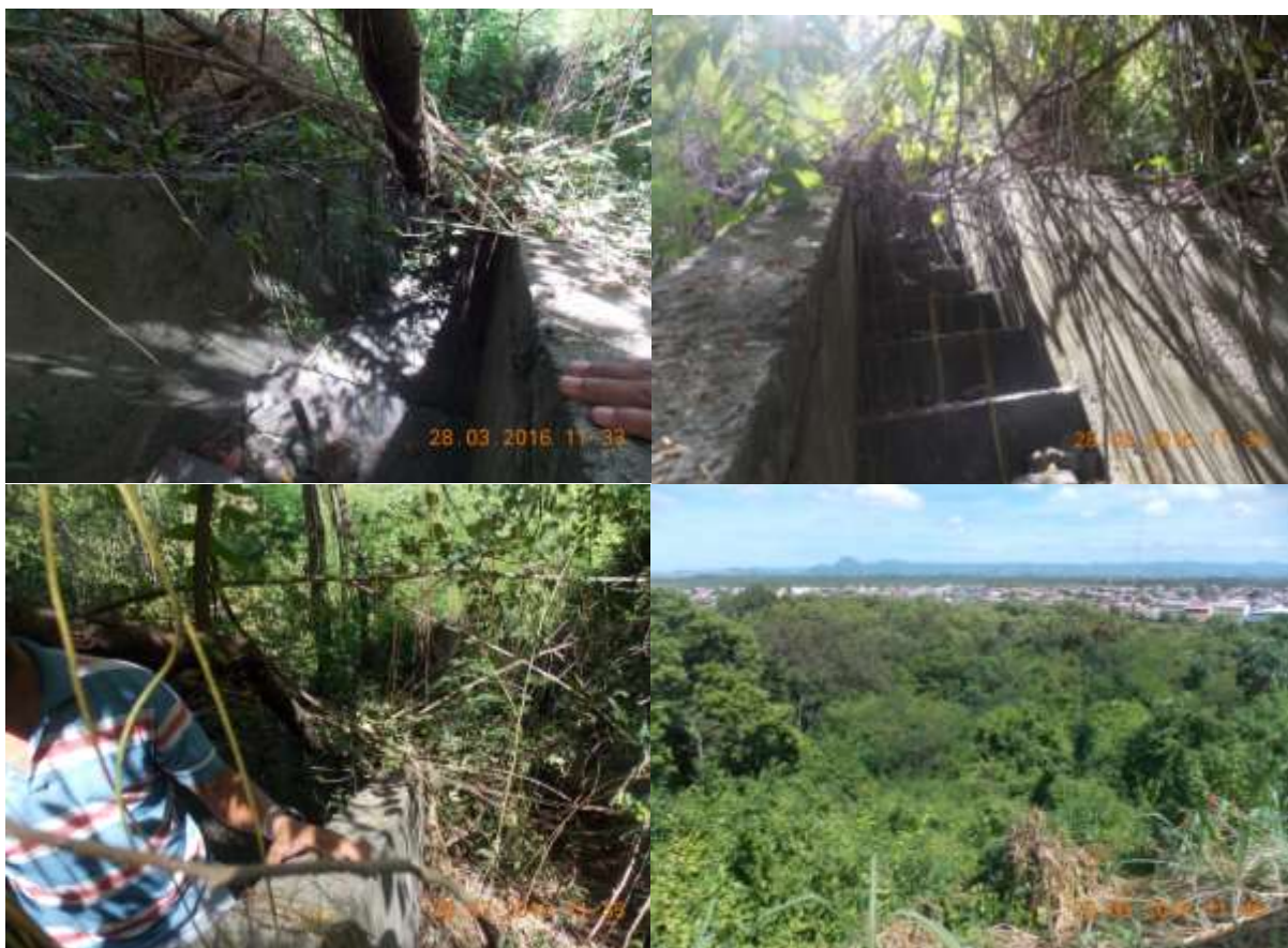
Figura 131: Registro fotográfico escada dissipadora 01
