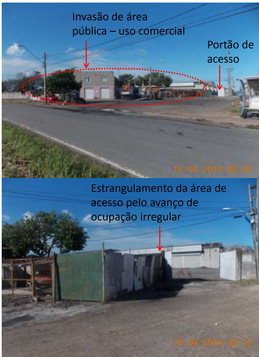
Figura 78: Registro de ocupação irregular sobre área pública - Estrangulamento da área de acesso ao empreendimento.
