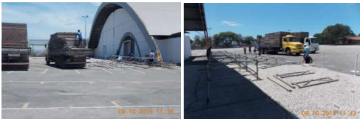
Figura 66: Operações de carga e descarga - 09/10/2015 - Início da montagem.
