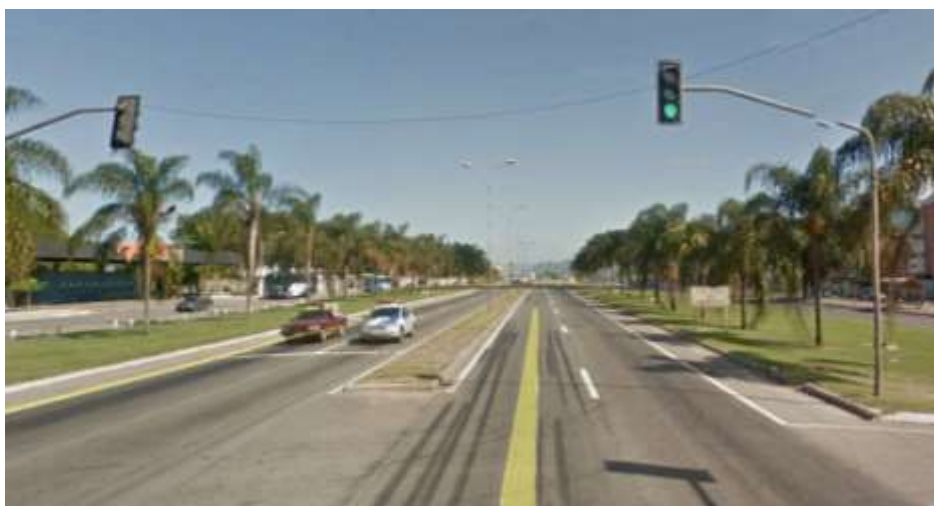
Figura 46: BR 101 - Pistas Centrais - Trecho Contorno (Imagem Google Earth - janeiro/2014).
