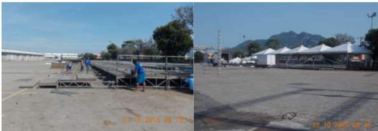
Figura 71: Operações de carga e descarga - 21/10/2015 e 22/10/2015 – Montagem
