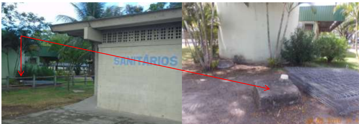
Figura 119: Indicação de fossa/filtro/sumidouro de atendimento aos escritórios
