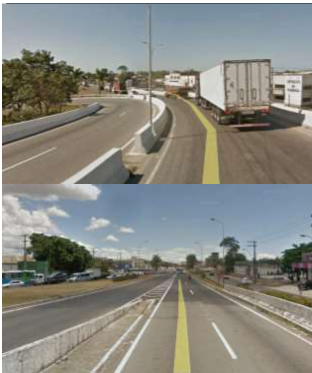
Figura 50: Viaduto de Carapina - Sentido Serra (Imagem Google Earth 2014)
