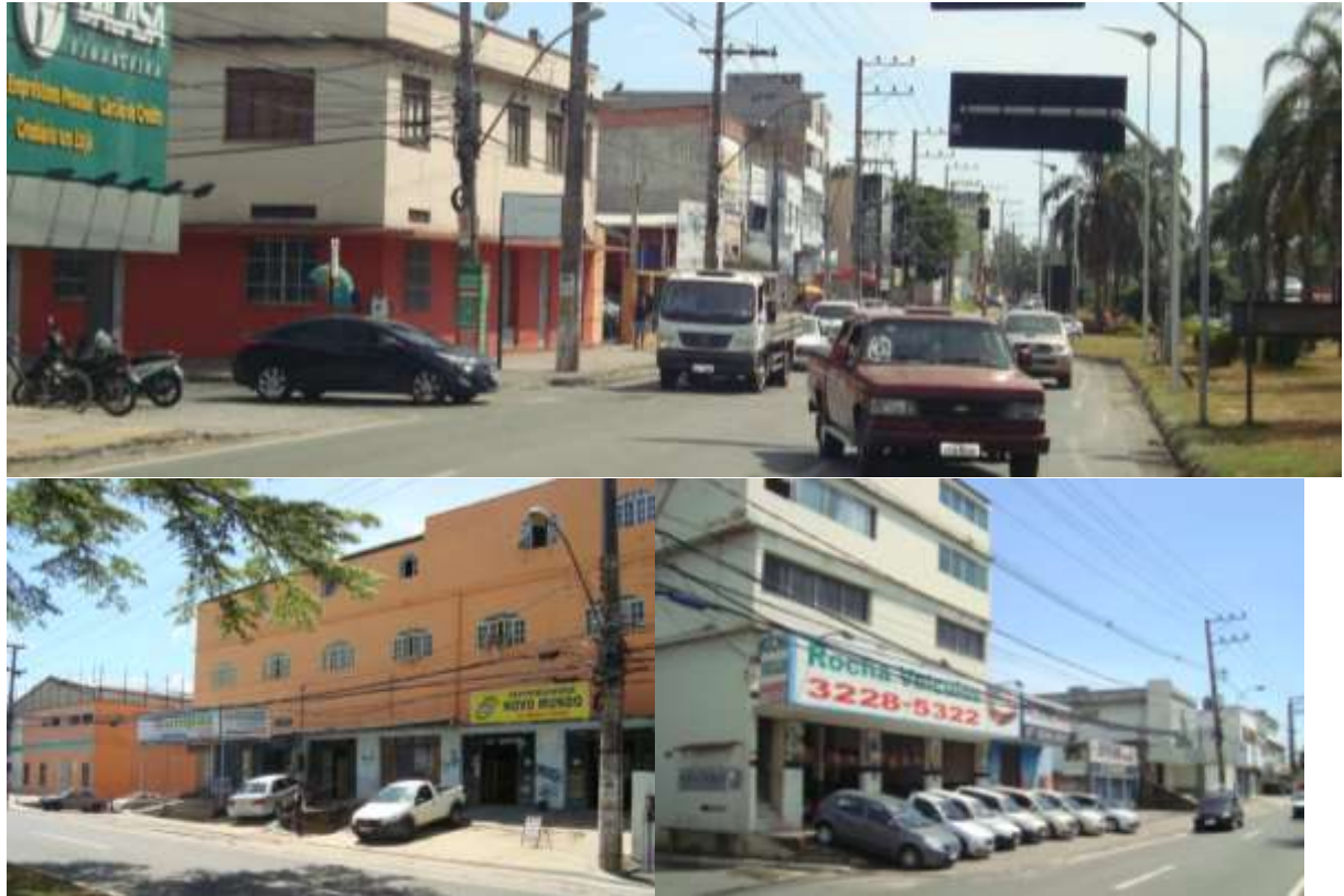
Figura 167: Conjunto edificado precário e envelhecido
