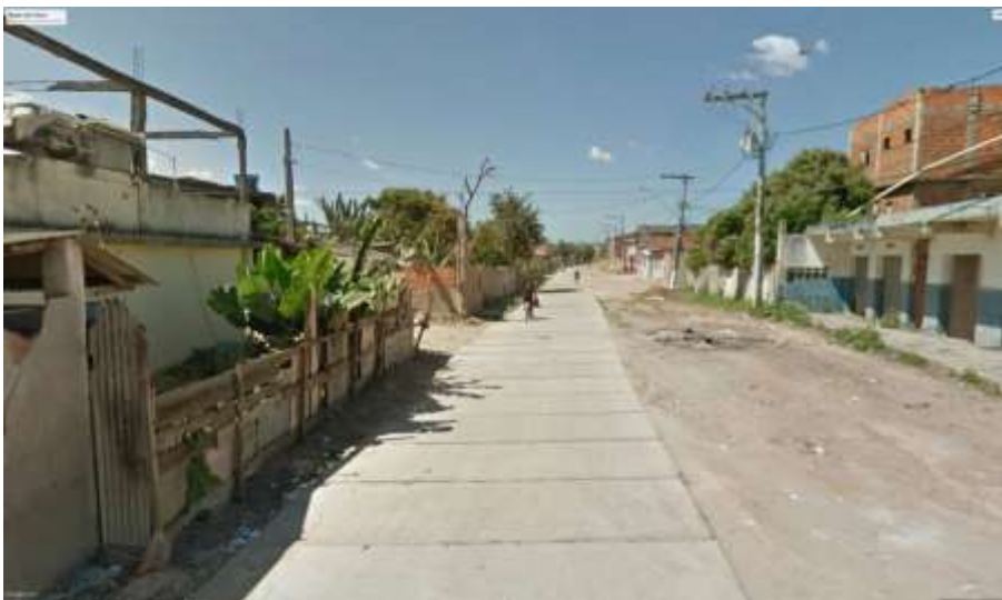
Figura 139: Canal de drenagem coberto por placas de concreto na Av. Presidente Dutra, Jardim Carapina.
