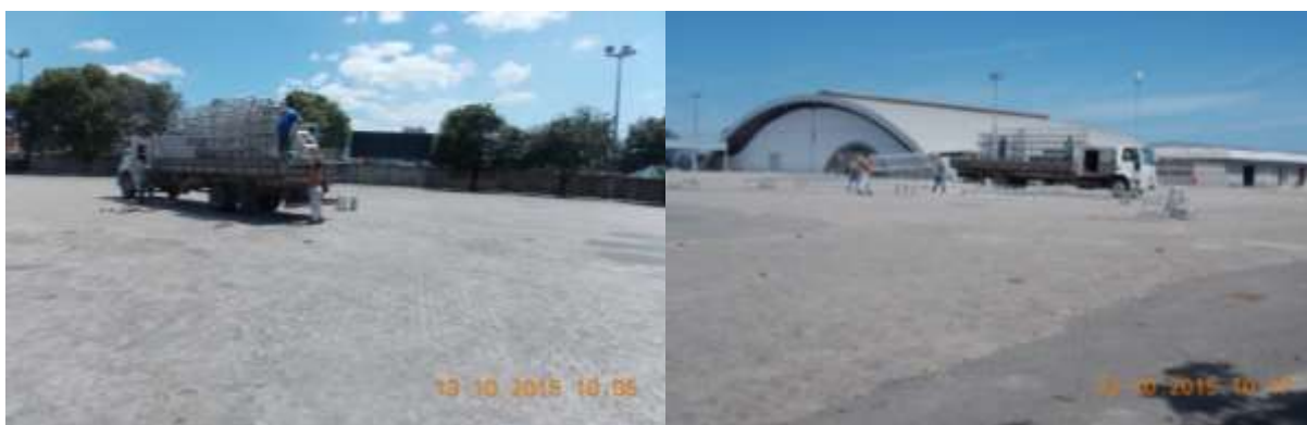
Figura 67: Operações de carga e descarga - 13/10/2015 - Início da montagem
