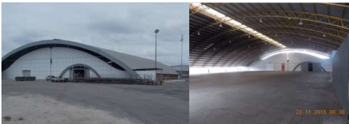
Figura 10: Imagens externa e interna - Pavilhão 01
