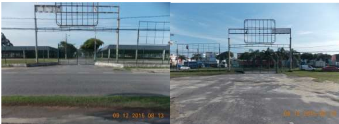
Figura 41: Portão 04 - Próximo aos pavilhões 04 e 05
