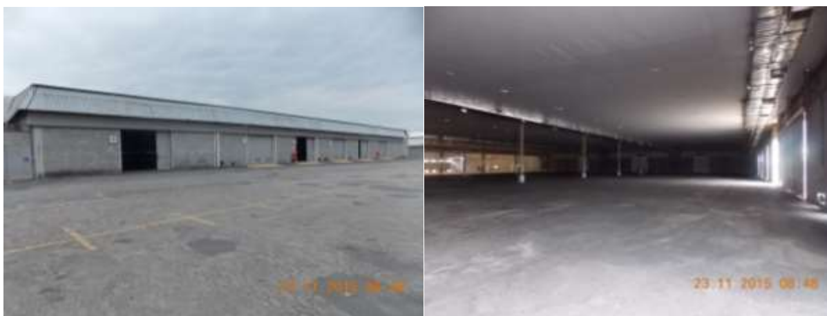
Figura 12: Imagens externa e interna – Pavilhão 02.
