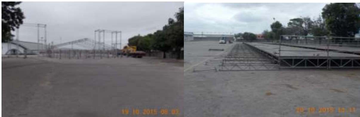
Figura 70: Operações de carga e descarga - 19/10/2015 e 20/10/2015 - Montagem
