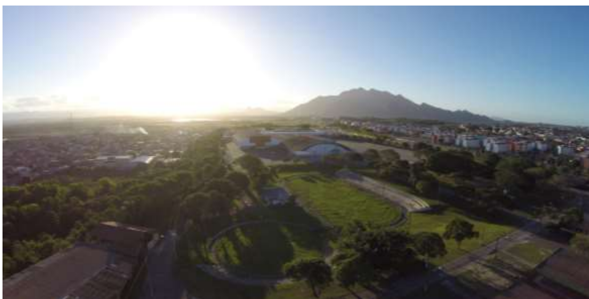
Figura 33: Visão geral da implantação do conjunto edificado.
