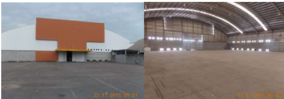
Figura 14: Imagens externa e interna - Pavilhão 03.
