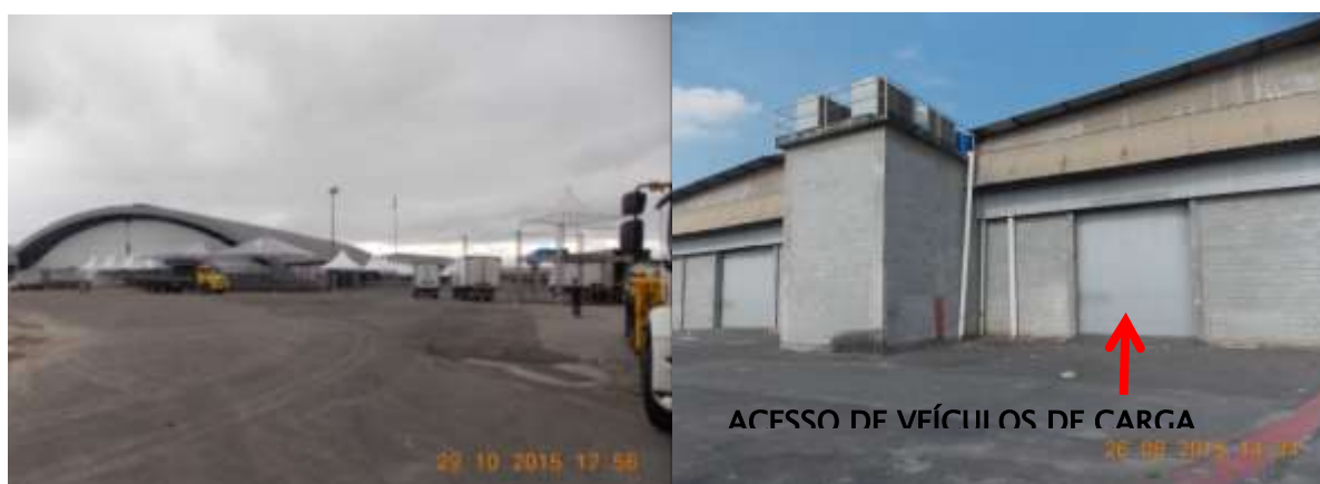
Figura 36: Exemplo de operações de carga e descarga em área externa e estrutura de acesso a veículos de carga nos pavilhões.
